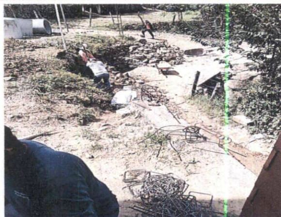
Foto 1: Área donde se está realizando el mejoramiento de muro perimetral del establecimiento educativo.
