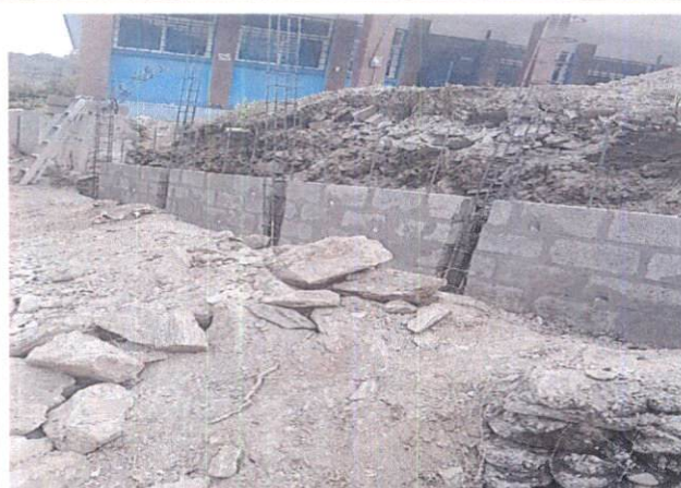
Foto 2: Área donde se está realizando el mejoramiento de muro perimetral del establecimiento educativo.
